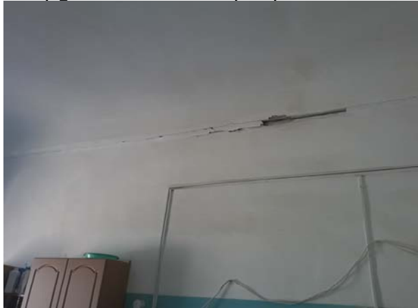
Разрушение плит перекрытий
